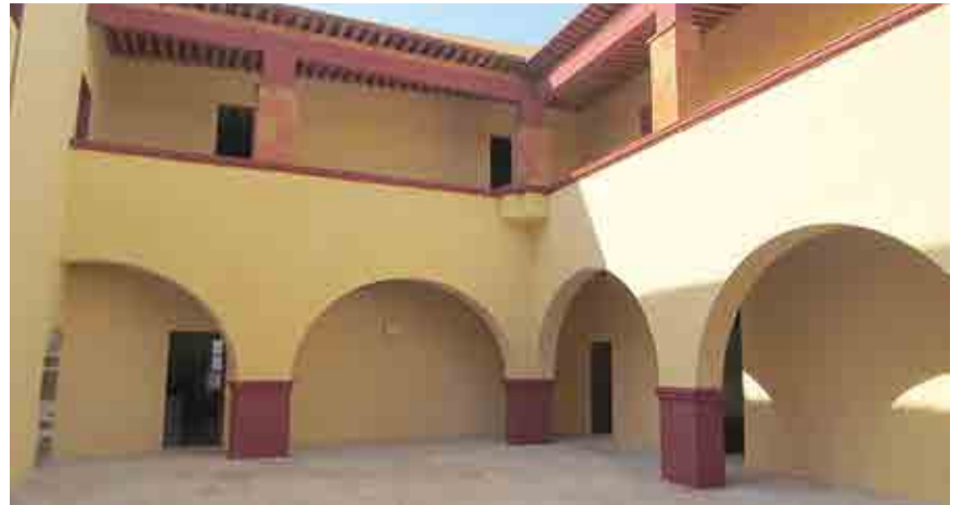
LOS TRABAJOS EN la planta baja ya fueron terminados.
