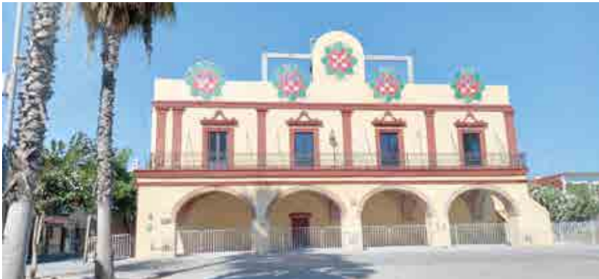
LA PRESIDENCIA MUNICIPAL de Jojutla está cerca de ser rehabilitada totalmente; sólo falta una etapa.
