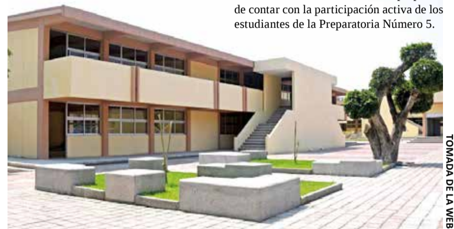
PERSONAL DE LA UECS brindó la plática en la Preparatoria 5 de la UAEM y planea visitar secundarias y primarias del municipio.
