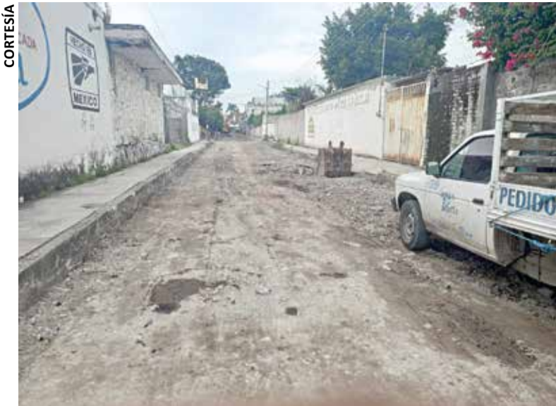
DESDE HACE VARIOS días cerraron algunas salidas al bulevar por la reparación de calles.
