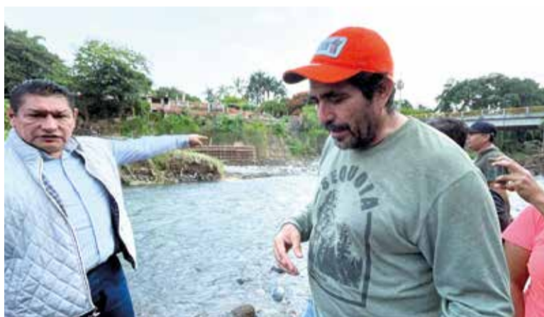
JESÚS CORONA (IZQUIERDA) y especialistas recorrieron la zona para conocer de cerca los daños estructurales del puente.
